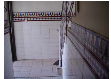
Escalier qui mène au 1er étage
