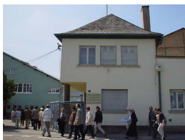
Entrée dans l'ensemble des bâtiments, par la rue de la fédération.
