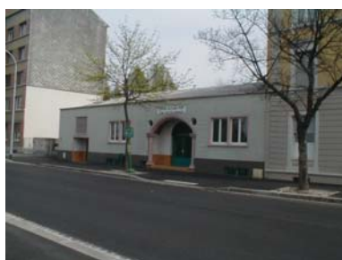
Le CCT vu de la rue Josué Hofer
